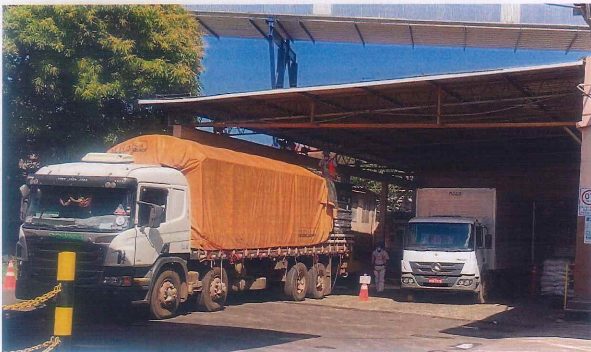
Imagem 21: Foto do prédio de Carregamento de Caminhões
